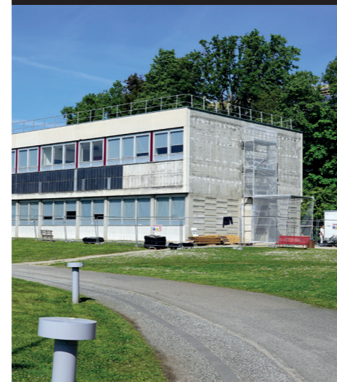
Rénovation thermique des façades de 5 bâtiments grâce au plan France Relance
