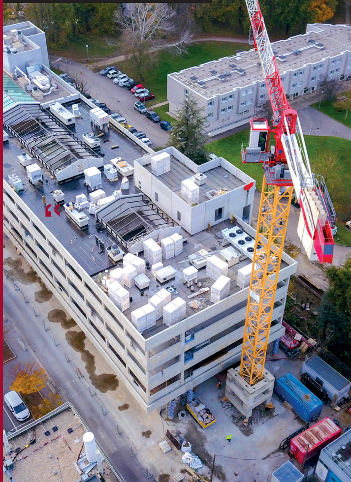
Construction de TMM2, bâtiment de formation et de recherche en tribologie et mécanique des matériaux
